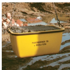
Kubel budowlany przy użyciu dźwigu
